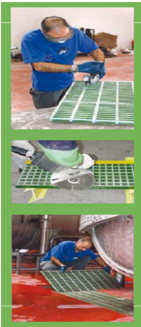
La larghezza dei supporti deve essere almeno pari all'altezza del grigliato in modo da distribuire adeguatamente gli sforzi. Utilizzando, per esempio un grigliato con altezza 30 mm, il supporto inferiore deve essere di almeno 30 mm per ogni lato.
